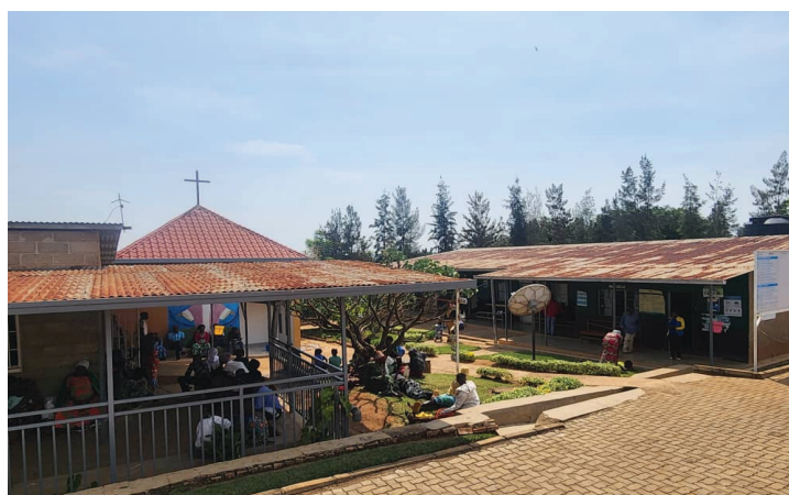
Les toitures du centre de Ruhuha sont fortement rouillées.
