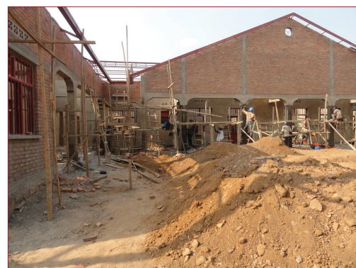
Le 7 juillet 2016, les murs sont terminés. La charpente métallique est posée.
